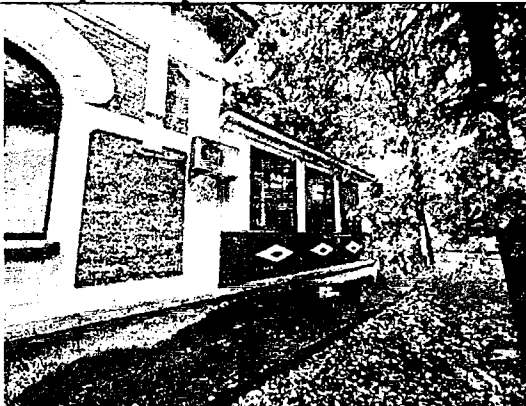
Фрагмент западного фасада (основной объем и пристройка)
