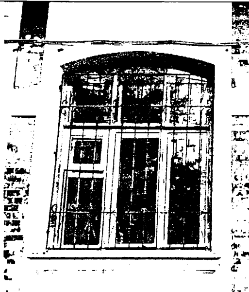
Южный и северный фасады.
